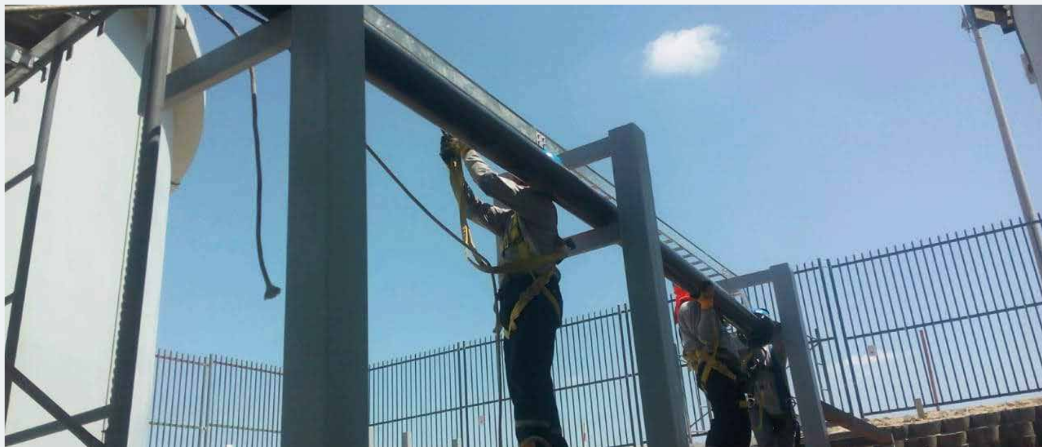
INSTALACIÓN DE TUBERÍAS
